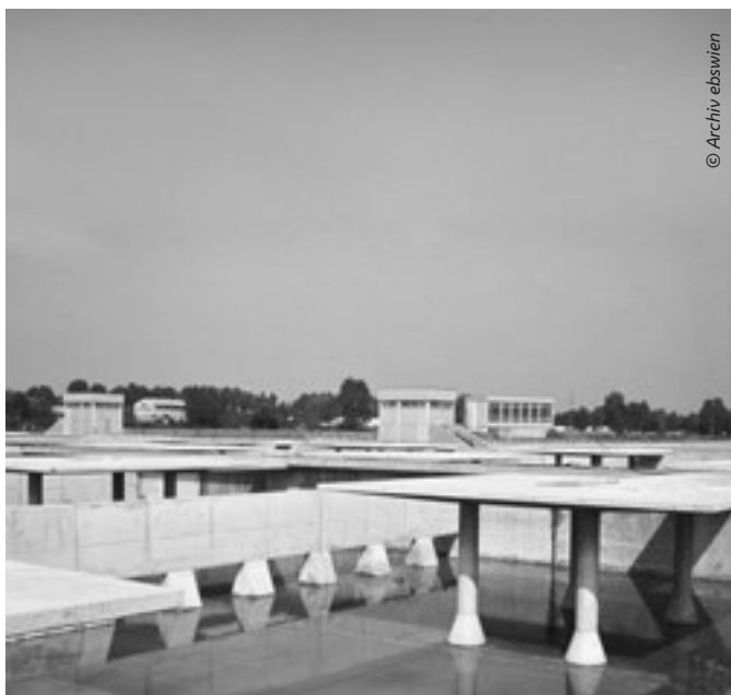
Belebungsbecken mit Basis für die Kreisellüfter
