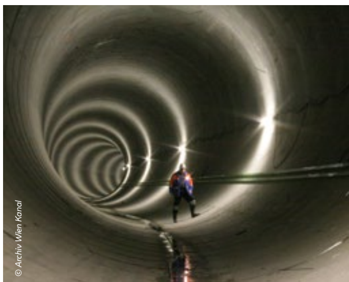
Neue Entlastungskanäle – hier der Wiental-Kanal – speichern bei Niederschlägen Mischwasser und entlasten so die Kläranlage.
