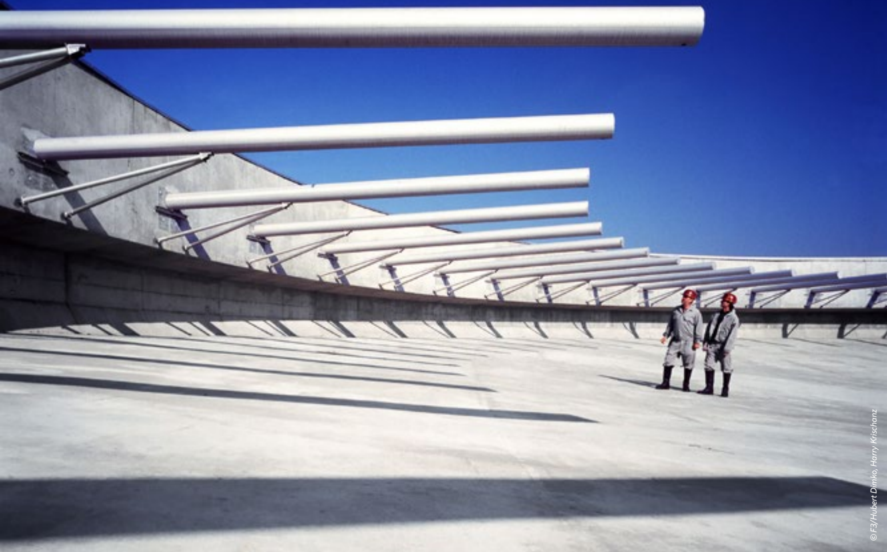
Gewaltige Dimensionen: die Ablaufrohre eines der 15 neuen Nachklärbecken
