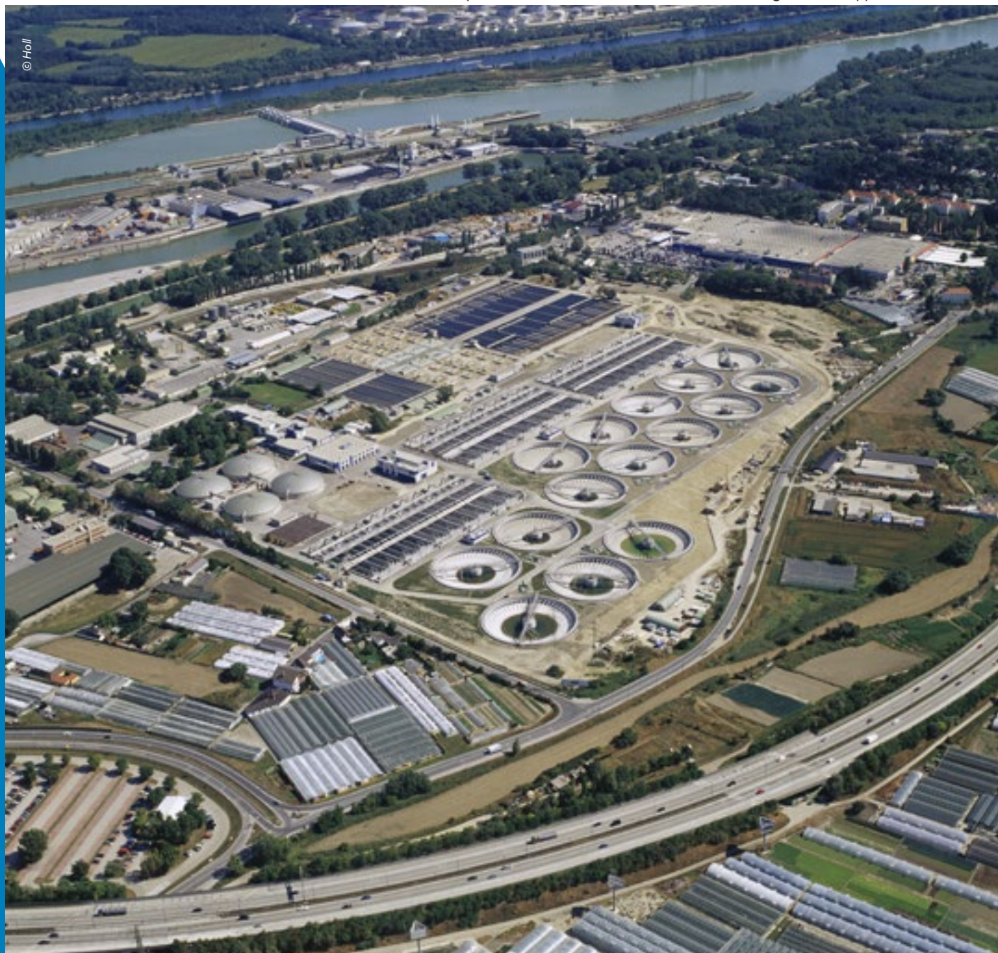
Luftaufnahme aus dem September 2004 : Die Arbeiten an der Erweiterung stehen knapp vor dem Abschluss.
