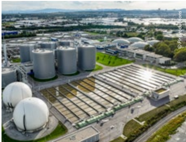
Vorklärung mit Schlammbehandlungsanlage
