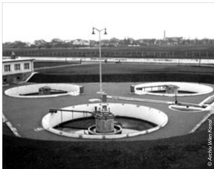
Die Emscherbrunnen der Kläranlage Inzersdorf
