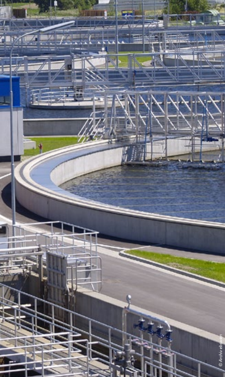
Eröffnungs-Rundfahrt über die erweiterte Hauptkläranlage
