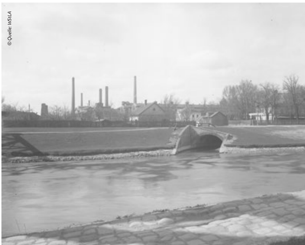
Ausmündung des Rechten Hauptsammelkanals in den Donaukanal
