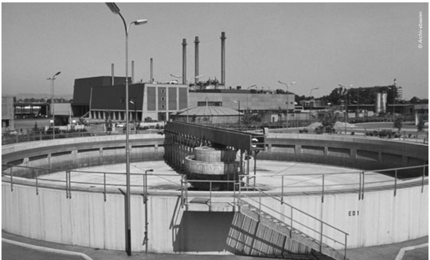
Schlammverdicker der Hauptkläranlage mit Blick auf die Verbrennungsanlagen der Entsorgungsbetriebe Simmering (EbS)
