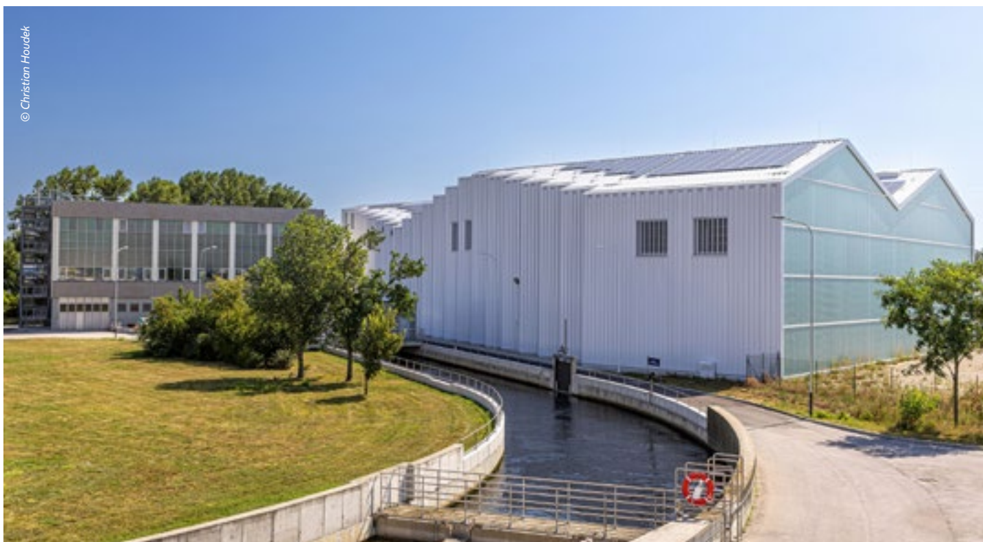
Die Großwärmepumpenanlage am Ablauf der Wiener Kläranlage
