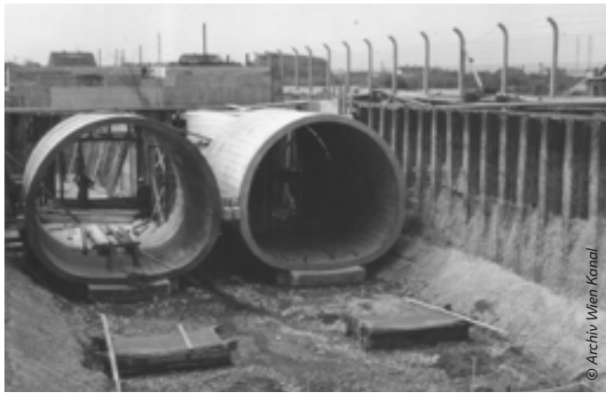
Arbeiten an der Verlängerung des Rechten Hauptsammelkanals ...
