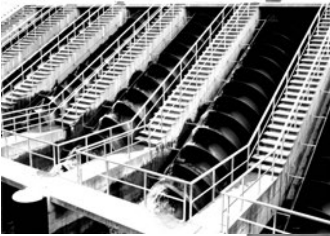
Schneckenhebewerk
