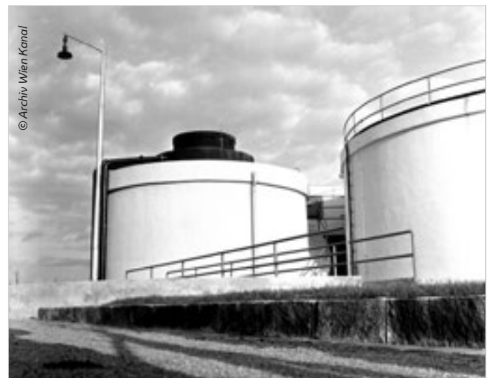
Blick auf die Hochleistungstropfkörper
