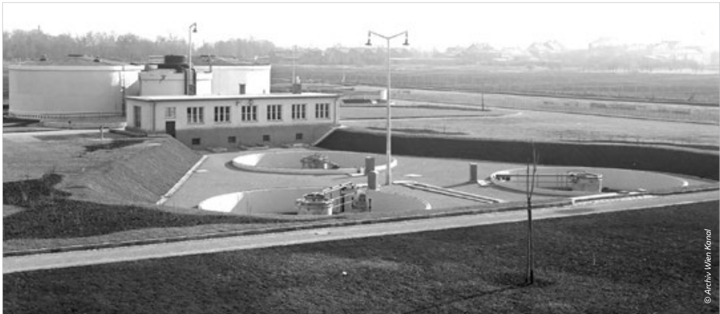
Kläranlage Inzersdorf: Im Vordergrund die Emscherbrunnen, hinten die beiden Hochleistungstropkörper
