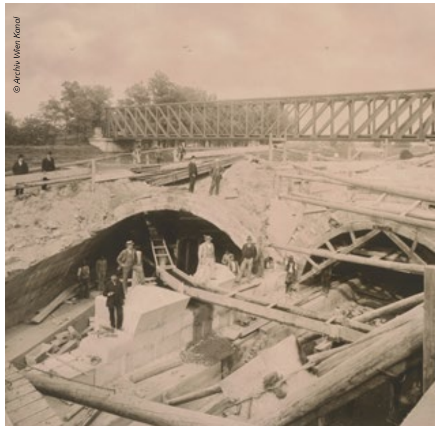
Bau der ersten Ausmündung des RHSK in den Donaukanal
