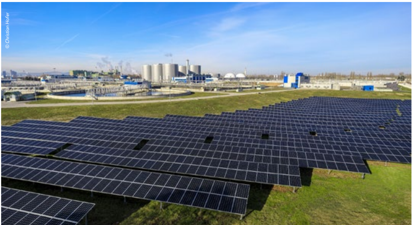
Ein Teil des Solarkraftwerks der Wien Energie auf dem Betriebsgelände der Wiener Kläranlage
