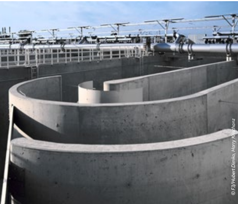
Belebungsbecken der 2. biologischen Reinigungsstufe in Bau ...
