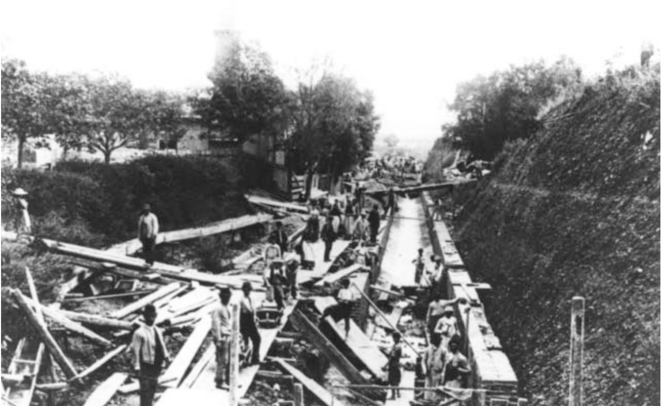
Abb. 41, Die Kanalisierung des Alserbachs nächst dem ehemaligen Badehaus in Dornbach 1893, Blickrichtung stadteinwärts
