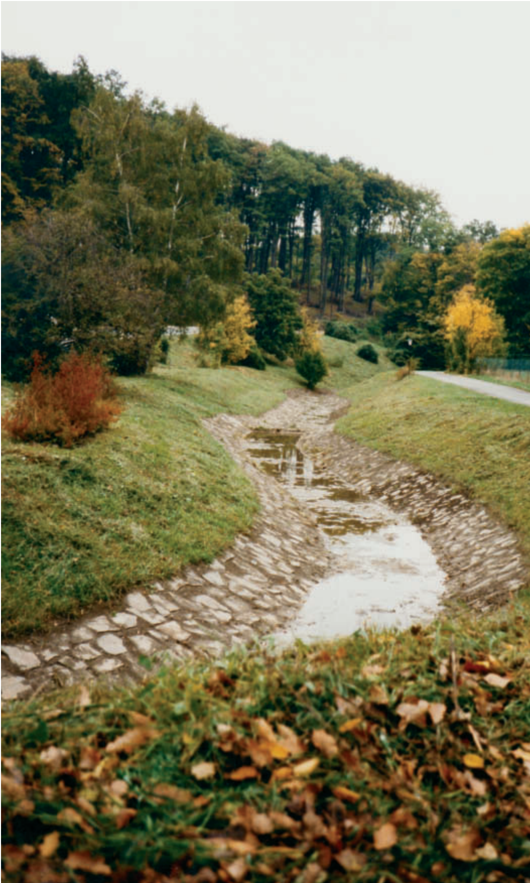
Abb. 26 Der hart verbaute Alsbach in seinem Oberlauf nächst der Neuwaldegger Straße 1990 vor der Renaturierung durch die MA 45
