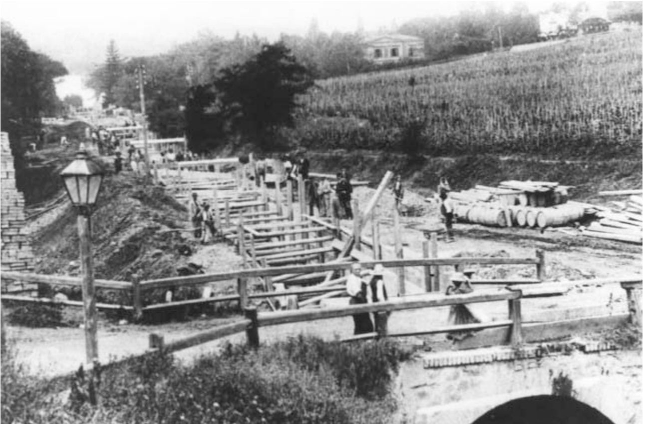
Abb. 42, Die Einwölbungsarbeiten in der späteren Alszeile von der Badgasse (heute Vollbadgasse) stadtauswärts, 1893
