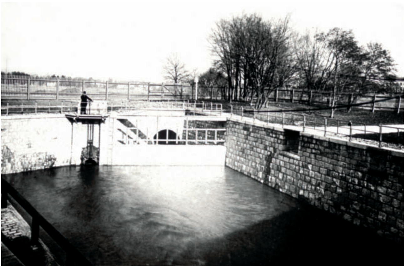
Abb. 10, Das Spülbecken der Lainzer-Bach-Einwölbung in Lainz um 1910
