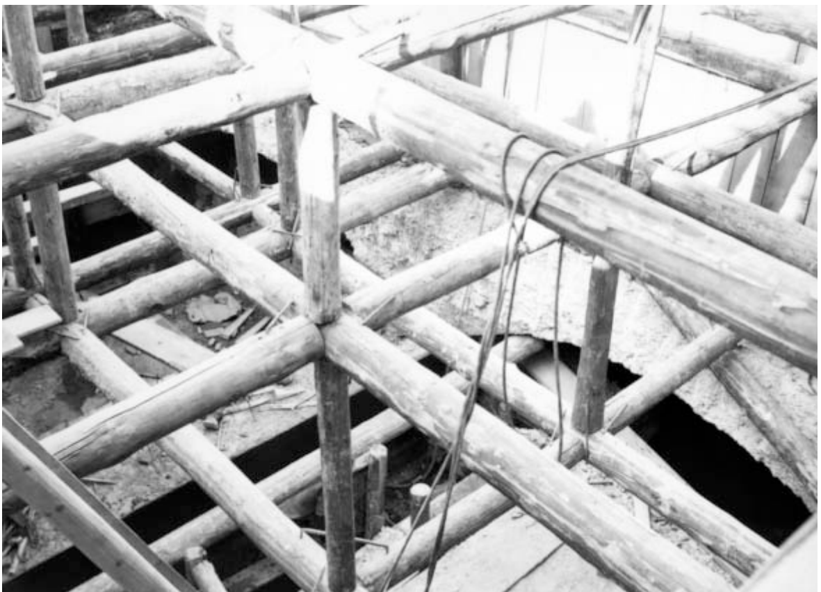
Die Umbauarbeiten des alten Alsbachprofils um 1950
