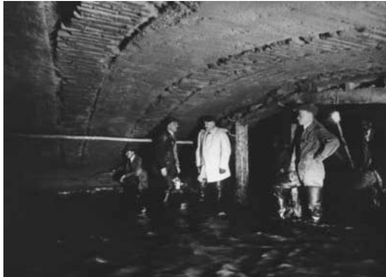
Abb. 63 Vermessungsarbeiten im alten Alserbachprofil, 1947
