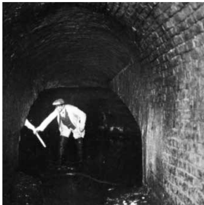
Abb. 38 Die alte Währinger-Bach- Einwölbung von 1848
