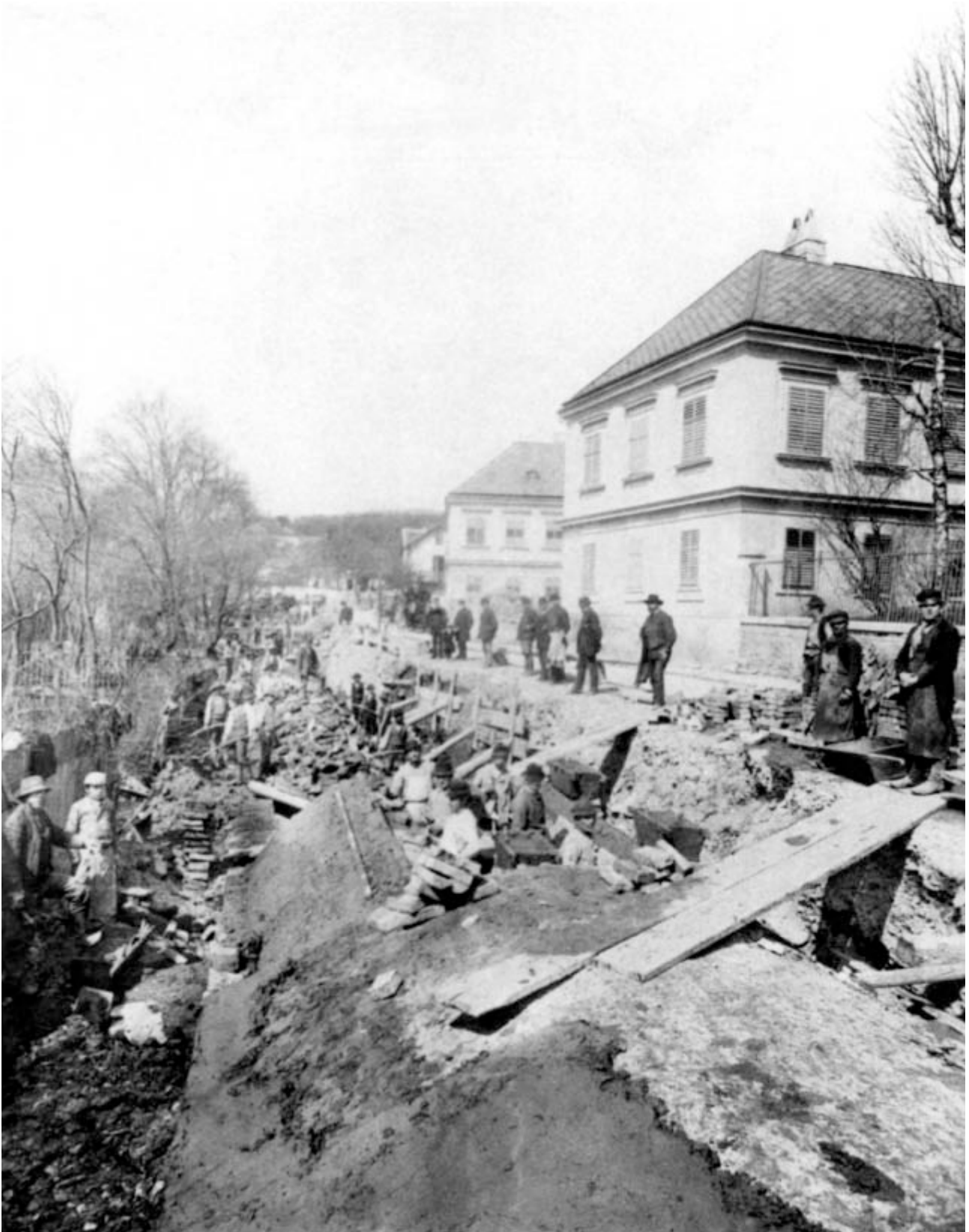
Abb. 40, Die Bauarbeiten der Alsbacheinwölbung der ehemaligen Gemeinde Neuwaldegg in der Neuwaldegger Straße werden 1885 vollendet
