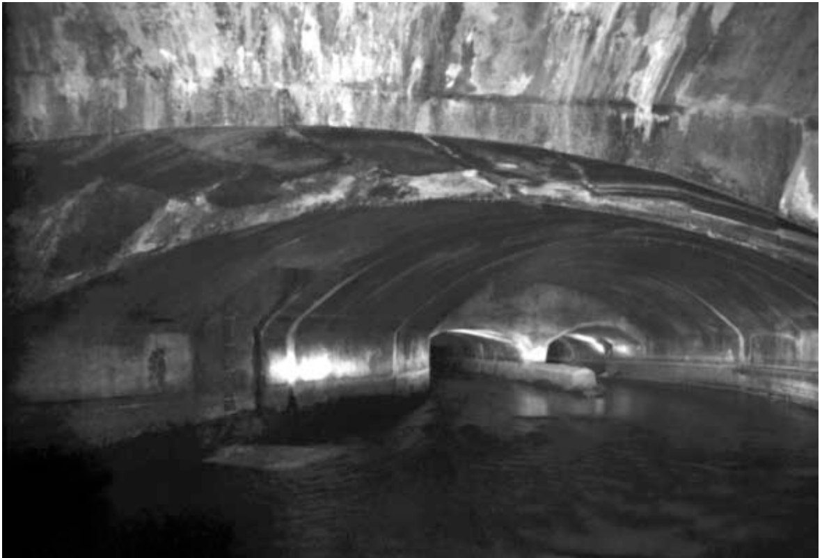
Abb. 62, Das fertig gestellte Vereinigungsbauwerk
